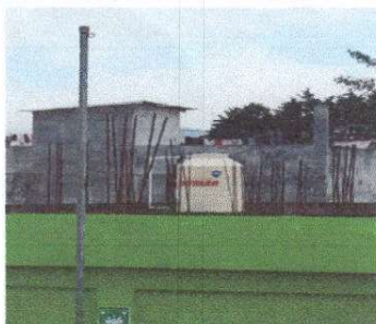
Foto 5: Instalación de Rotoplast.
